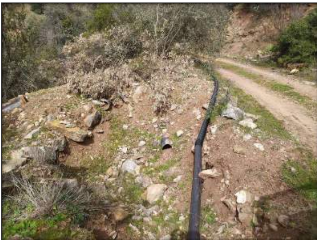
Φωτογραφία 8: Τμήμα δικτύου του Δυτικού τομέα όπου έχει τοπικά αντικατασταθεί με πλαστικές σωλήνες, η τοποθέτηση έγινε επιφανειακά.
