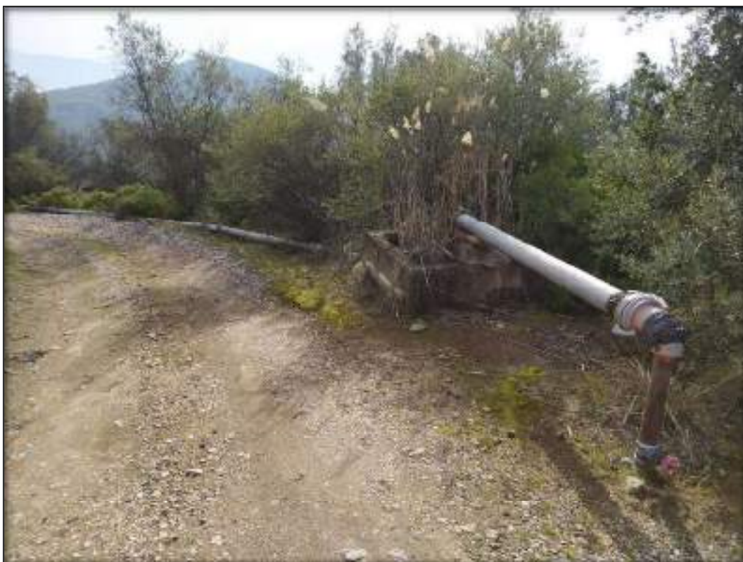
Φωτογραφία 7: Υφιστάμενο δίκτυο Ανατολικού τομέα, στη θέση αυτή λόγω της συνδεσμολογίας εντοπίζονται μεγάλες απώλειες νερού.
