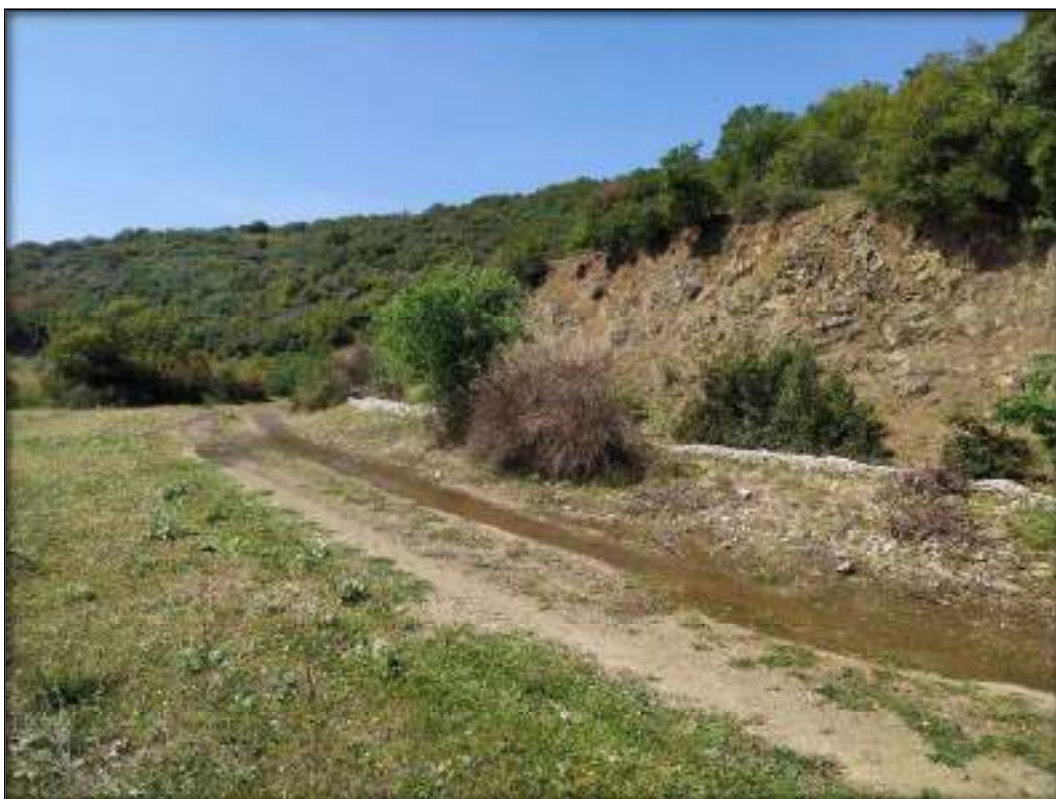
Φωτογραφία 6: Τμήμα της υφιστάμενης διώρυγας μεταφοράς όπου εντοπίζονται σημαντικές απώλειες νερού.
