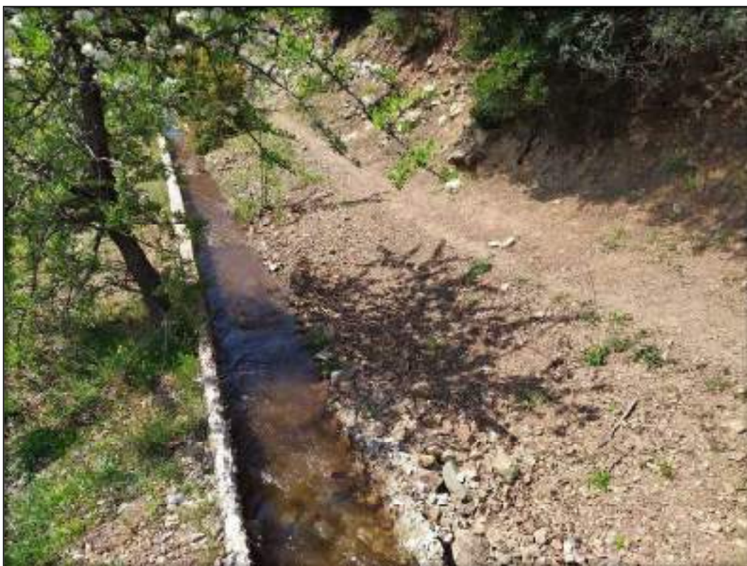
Φωτογραφία 2: Τμήμα της υφιστάμενης διώρυγας μεταφοράς όπου διακρίνονται οι εκτεταμένες φθορές, καθώς και οι κατολισθήσεις πετρωμάτων που εισέρχονται εντός της διατομής.
