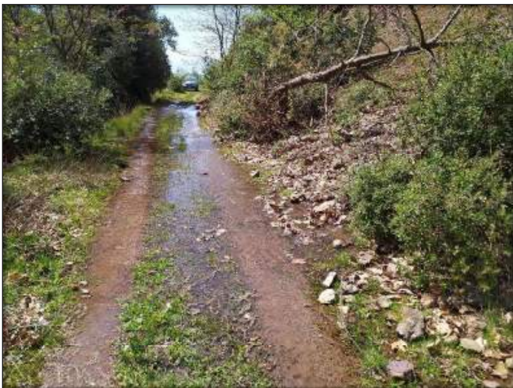
Φωτογραφία 5: Τμήμα της υφιστάμενης διώρυγας μεταφοράς όπου εντοπίζεται έμφραξη της διατομής και απορροή ποσότητας ύδατος εκτός της διώρυγας.
