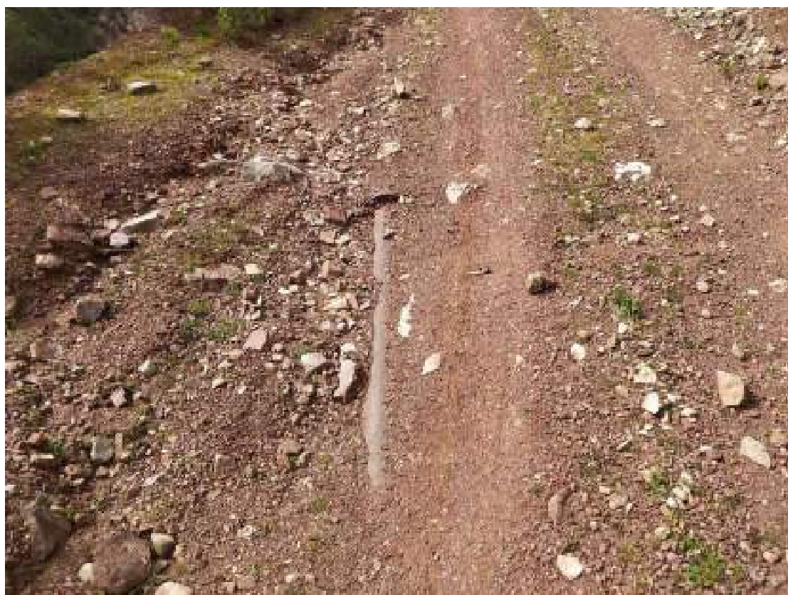
Φωτογραφία 10: Δίκτυο Δυτικού τομέα, διακρίνεται μεταλλική σωλήνα σε τμήμα αγροτικής οδού όπου διέρχονται αγροτικά μηχανήματα.
