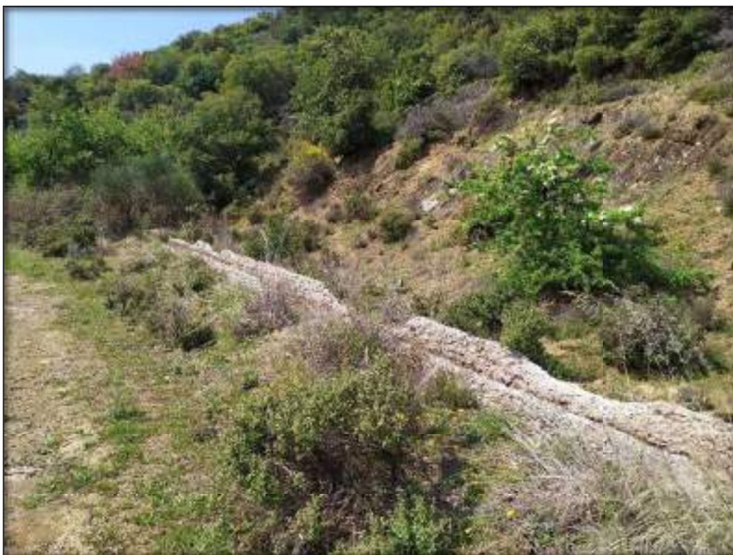
Φωτογραφία 1: Τμήμα της υφιστάμενης διώρυγας μεταφοράς όπου διακρίνονται οι εκτεταμένες φθορές των πλευρικών τοιχίων.
