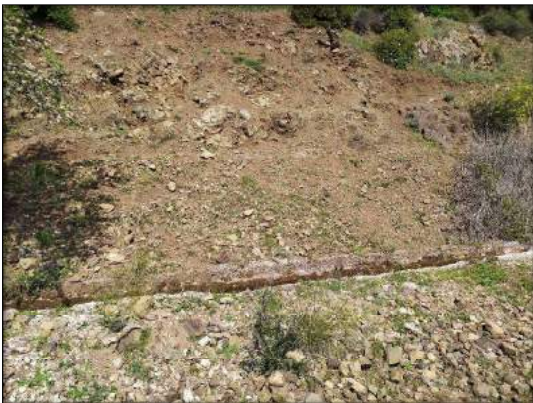
Φωτογραφία 3: Τμήμα της υφιστάμενης διώρυγας μεταφοράς όπου διακρίνονται έντονες κατολισθήσεις πετρωμάτων που εισέρχονται εντός της διατομής.
