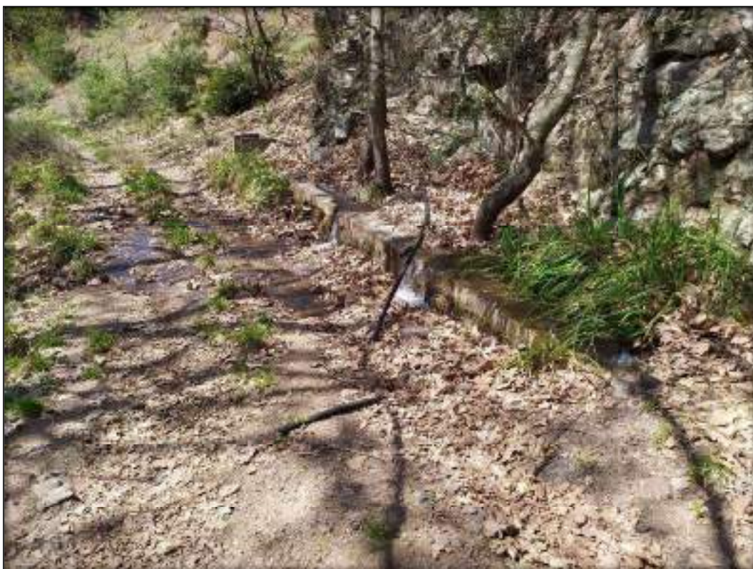
Φωτογραφία 4: Τμήμα της υφιστάμενης διώρυγας μεταφοράς όπου εντοπίζονται σημαντικές απώλειες νερού.
